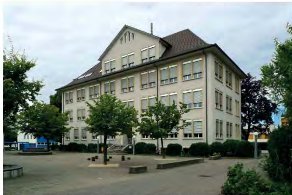
Ansicht Hauptfassade von Nordosten (2014)
