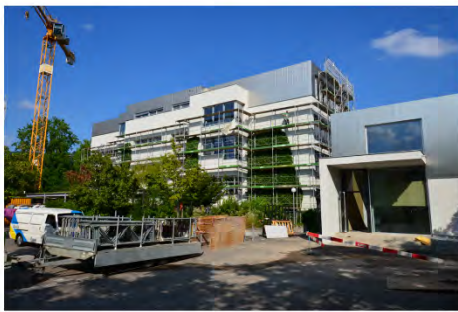
Margelstrasse 6, Ansicht von Westen, 31.07.2014.
