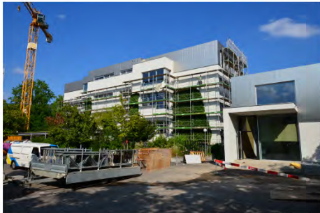
Margelstrasse 6, Ansicht von Westen, 31.07.2014.
